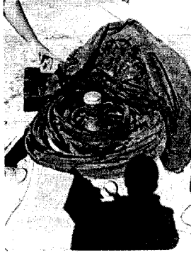
Base de equipo de bombeo
