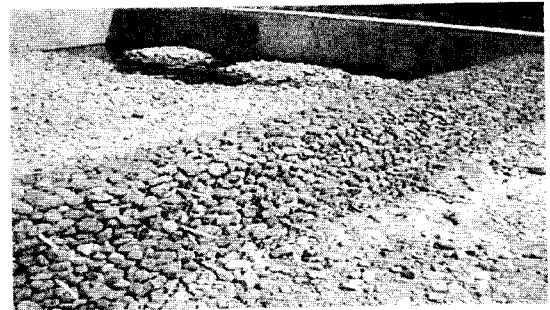
Humedal con grava 4" y malla tipo gaviones
