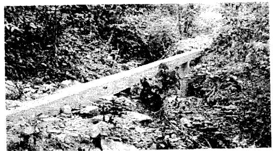
Encofrado de tubería de PAD de 8"
