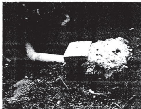
Paso de carretera con tubería de acero
